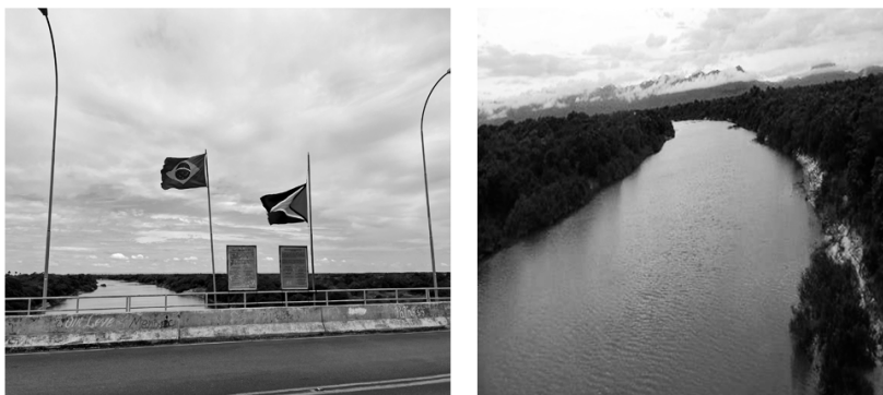
Figura 3: Fotografias da ponte e do rio Tacutu
